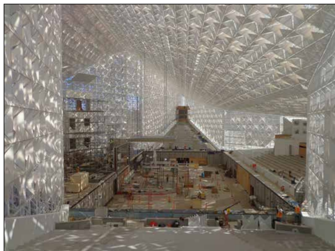
La Christ Cathedral durante la ristrutturazione
