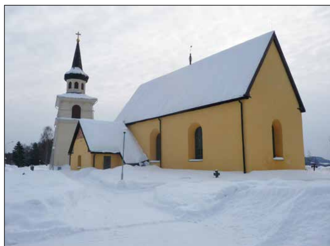
Un metro e mezzo di neve ha accolto le squadre di installazione e accordatura alla chiesa di Boteå nel Marzo 2018.
