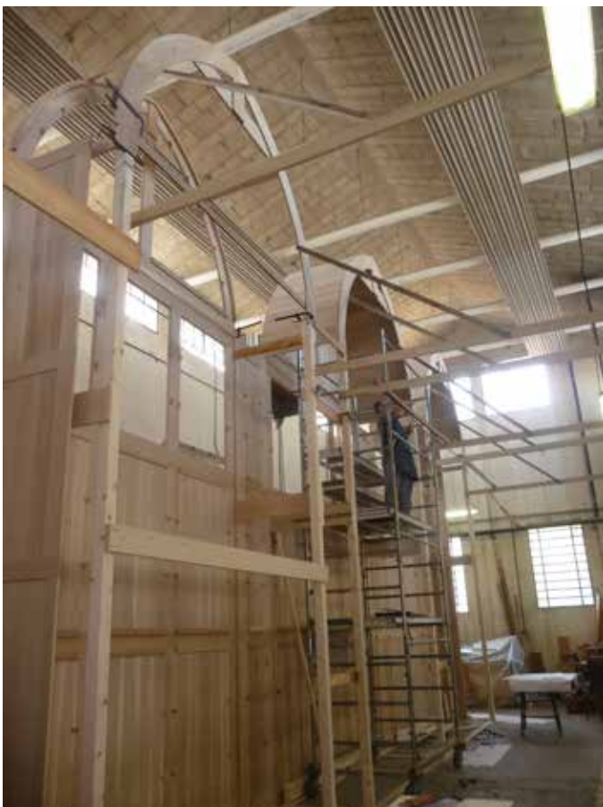
Una delle casse in rovere in fase di assemblaggio in laboratorio
