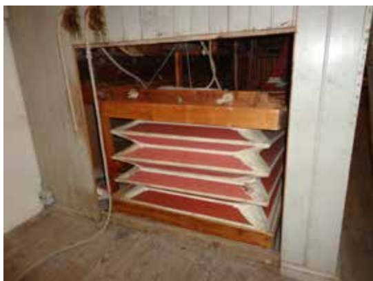
A lato sinistro della cassa, rimuovendo un pannello, si può vedere uno dei due grandi mantici a libro, che possono essere azionati manualmente con il tiro di corde.
